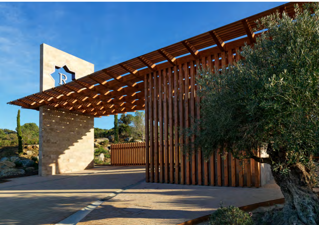
Main entrance la Gran Reserva.
